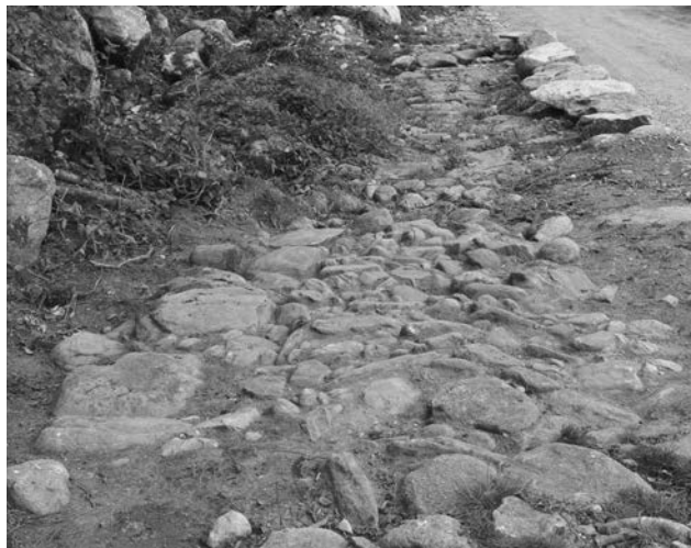
Fig. 49. Sordevolo, strada Prera-Monti. Vecchio sedime, sondaggio 1.
